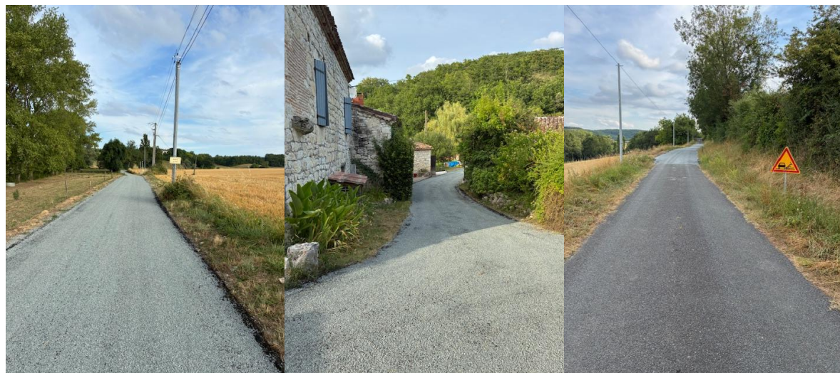
Nos travaux de rénovation des routes (Pis, Las Gonies, Courbiac)
